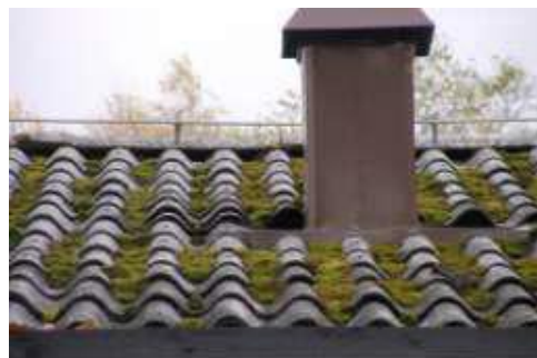
Bild 6. Hur ser det ut under takpannorna? Är underlagspappen hel? Hur lång tid är det tills den skall bytas? (Foto: Anneling Tobin Consult AB)
